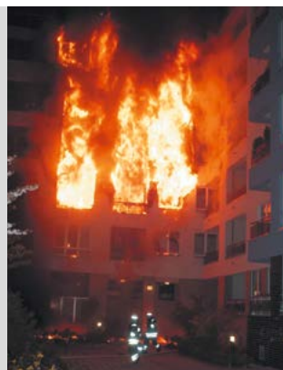
Riesige Flammwalzen beim Berliner Brand durch 5 cm Hartfaserplatten auf den Wänden und Mitbrand des Polystyrols. Deutlich schlagen die Flammwalzen aus den Fenstern - und nicht aus der Fassade..
