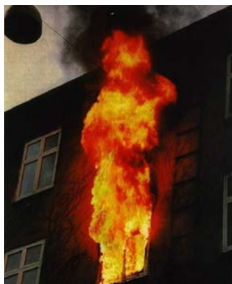
Zimmerbrand nach 15 Minuten. Ziegelfassade unbrennbar.
