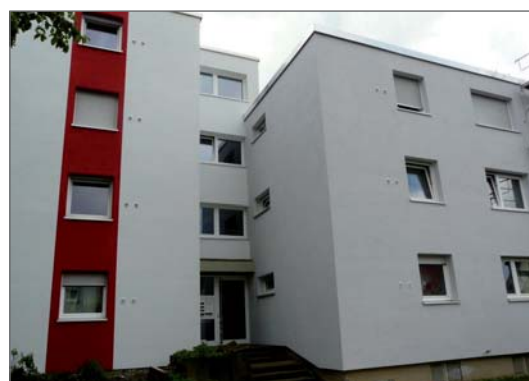
Fertige Fassade mit integrierten Wärmetauschern
