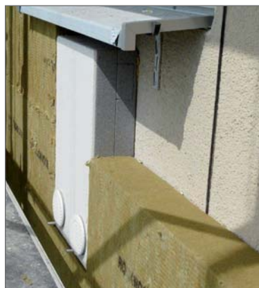
Einbau des Wärmetauschers in die Mineralwolldämmung
